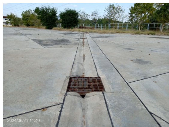
จัดทำรางระบายน้ำ และรางรวบรวมน้ำเสียไว้บริเวณจุดต่างๆ ภายในสถานีก๊าซธรรมชาติหลัก
