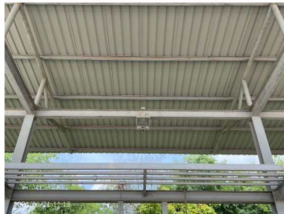
ระบบไฟฟ้าที่ใช้ภายในสถานีก๊าซธรรมชาติหลักเป็นชนิดป้องกันการระเบิด (Explosion Proof)
