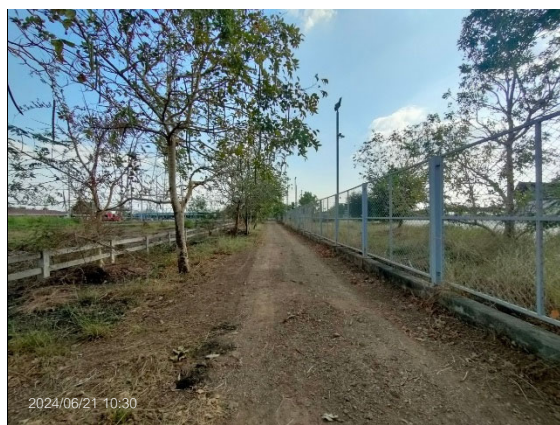
จัดทำแนวรั้ว และกำแพงปูนล้อมรอบพื้นที่ทุกด้านของสถานีก๊าซธรรมชาติหลัก
