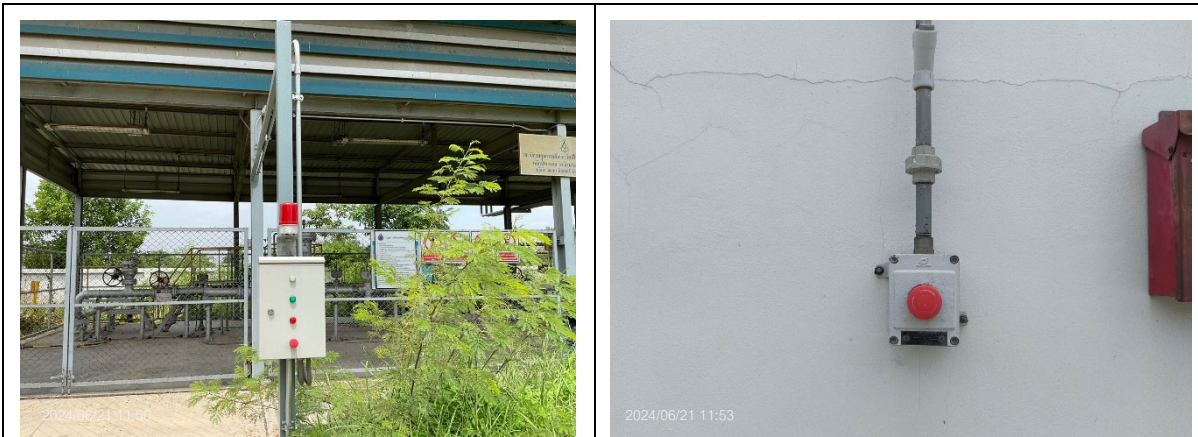
ติดตั้งระบบสัญญาณไฟแจ้งเตือนเมื่อเกิดเหตุฉุกเฉิน
