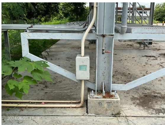
ระบบไฟฟ้าที่ใช้ภายในสถานีก๊าซธรรมชาติหลักเป็นชนิดป้องกันการระเบิด (Explosion Proof)
