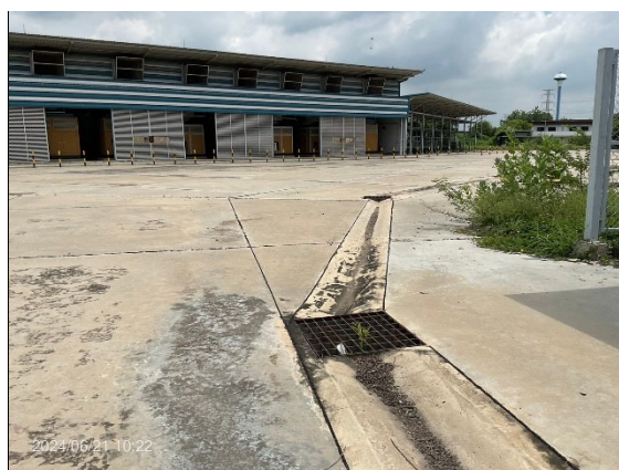
จัดทำรางระบายน้ำ และรางรวบรวมน้ำเสียไว้บริเวณจุดต่างๆ ภายในสถานีก๊าซธรรมชาติหลัก
